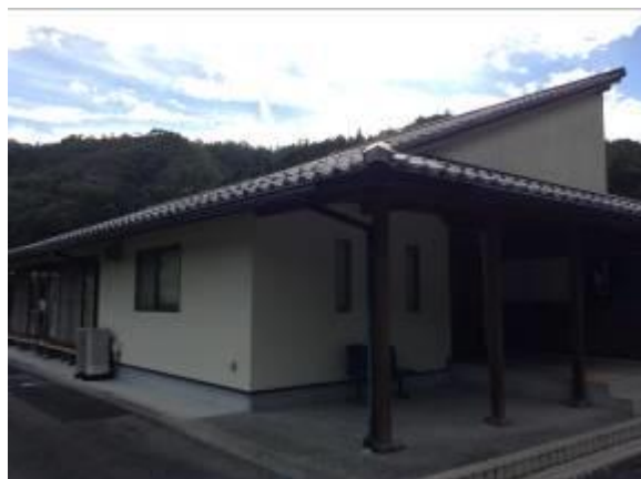
自治会公民館への太陽光パネル設置（災害対策）
