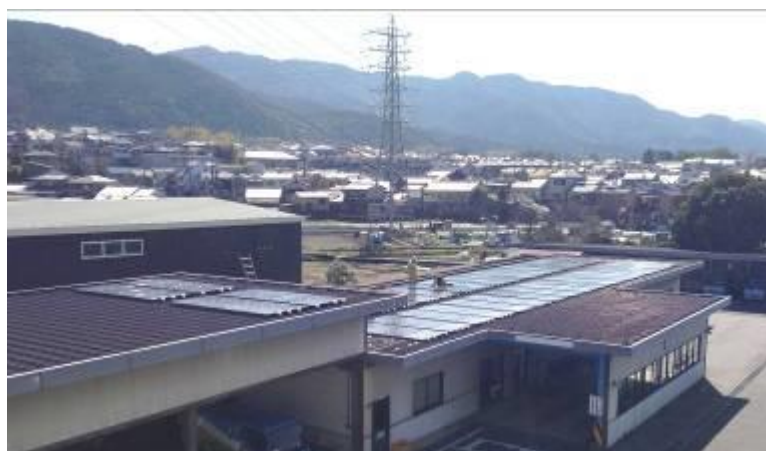
図表4-2 公共施設の屋根に設置された市民発電所(京都市 山科区まち美化事務所)
