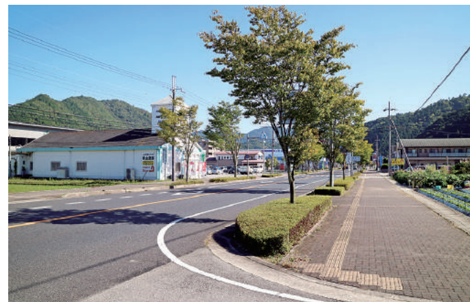
国道176号沿道：農地と店舗が混在(まちのエリア用途B)
