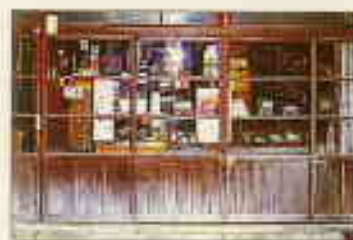
木製枠の引違ガラス戸
