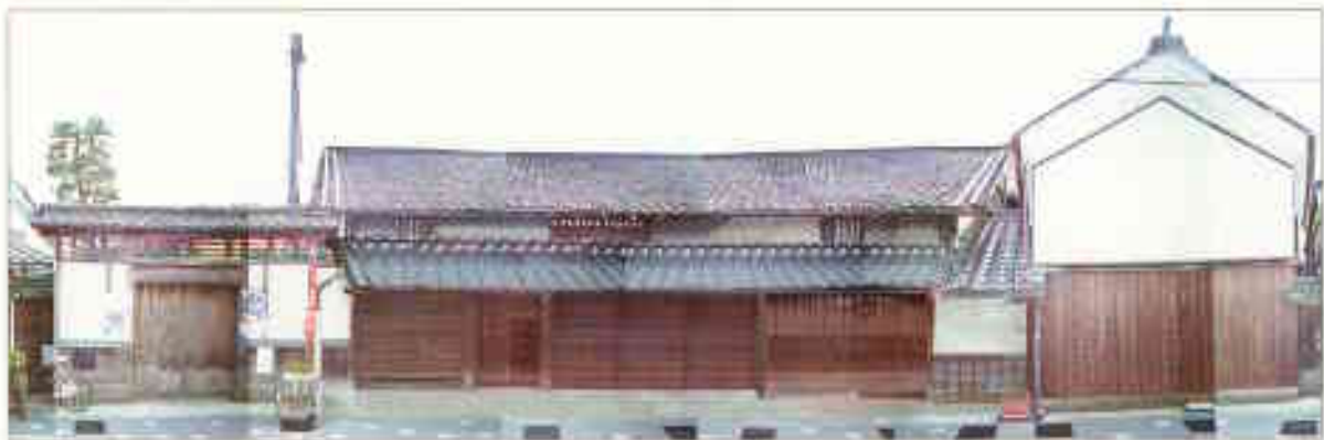
復元案（アルミサッシガラスをしとみ，大戸に復元）
